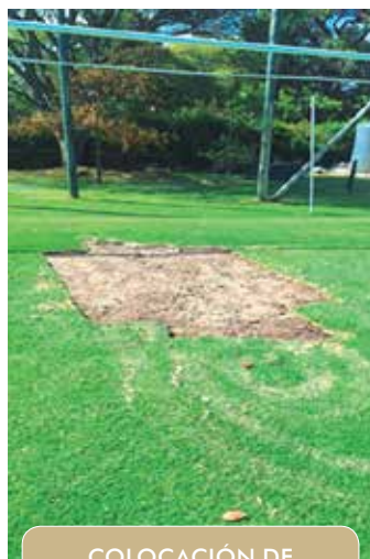
COLOCACIÓN DE CÉSPED EN TEPES
