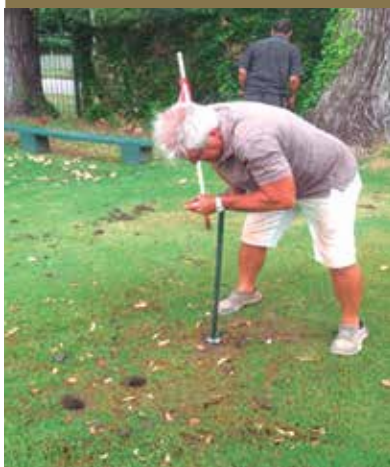
REALIZACIÓN DE FILTROS VERTICALES
